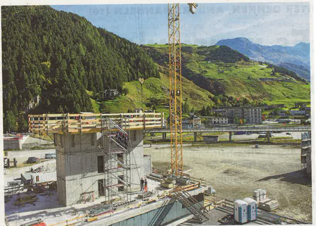
Das Riesenprojekt kommt nur langsam voran: Bau eines Swiss-Alps-Appartementhauses in Andermatt. FOTO: SIGI TISCHLER, KEYSTONE
